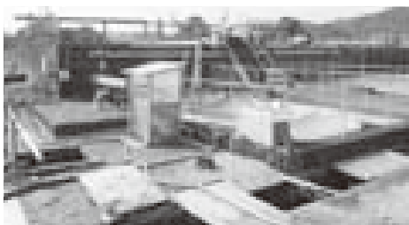
現排水処理場
